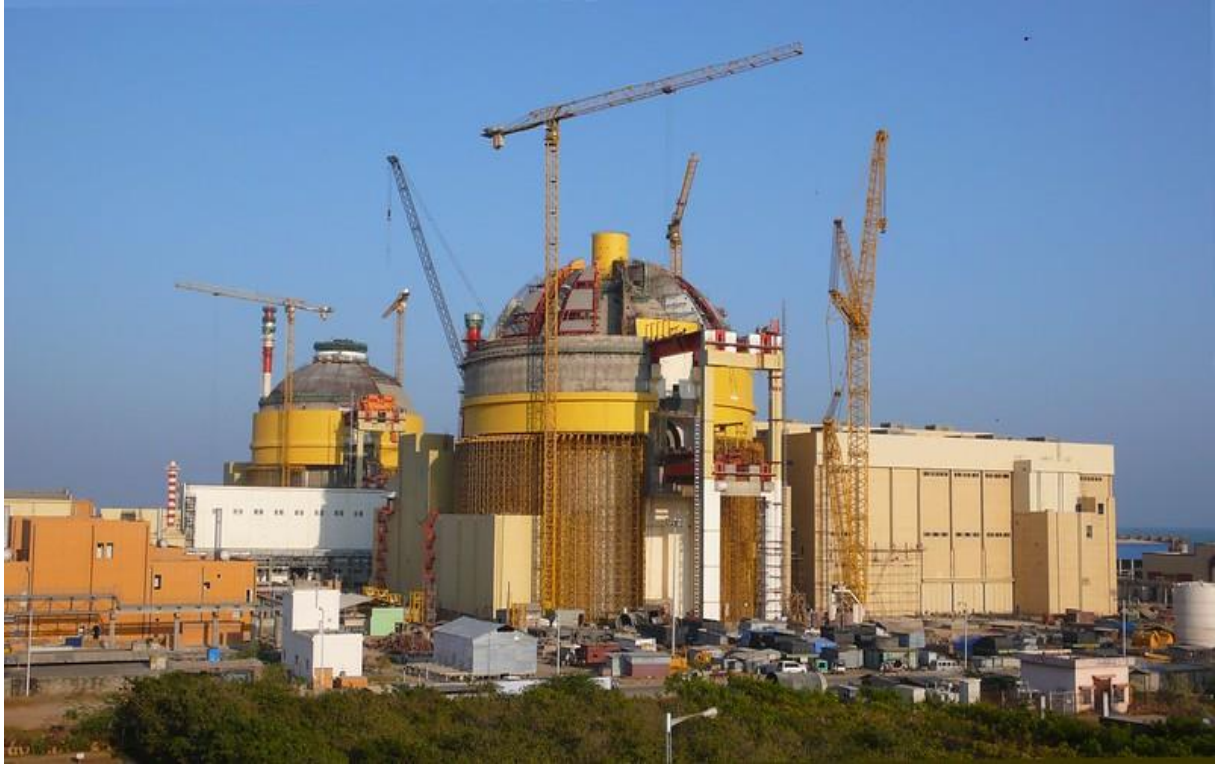
Rusya'nın Hindistan Kundakulam'da yaptığı reaktör binasının kalın duvarlı dış yapısı (Koruma Kabı/ Containment), Şekil : IAEA (Akkuyu'da yapılmakta olan reaktörlerin benzeri)
