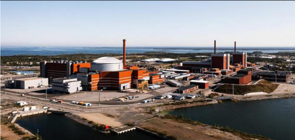
Şekil 1: Finlandiya Olkiluoto 3 nolu yeni nükleer reaktörü, solda, sağdaki bacalı binalar, eskiden beri işleyen reaktörler
