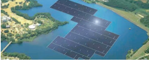
Su yüzeyine kurulan panellere bir örnek.
