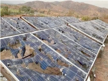
Şekil 1a,b. Dolu, kuvvetli yağmur, fırtına, kızgın güneş gibi kötü hava koşullarına dayanamayan güneş tarlası panelleri örneği ve açık bir çöplüğe atılan hurda paneller
