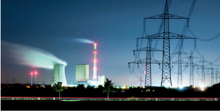
Şekil 1: Almanya'nın Kuzey Saksonya eyaletindeki Mehrum Taşkömürlü Elektrik santrali 250 m'lik ince uzun bacasıyla ve geniş soğutma suyu kulesiyle 650 MW net güçte elektrik üretiyor (kömür yakılmasıyla saatte havaya 2,5 milyon m 3 bacagazı ve 24 ton kül atıyor). Santralde taş kömürünün yanı sıra saatte 144 ton arıtma çamuru da yakılıyor. (Foto: dpa)
