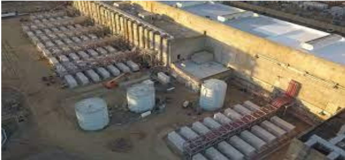
Şekil 3: Vistra Moss Landing Energy Power Plant şirketinin genişleterek Ağustos 2021'de işletmeye açtığı güneş bataryası sistemi, Florida'da.
