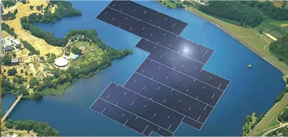
Şekil 4: Su yüzeyine kurulan panellere bir örnek
