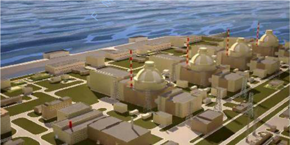
4 reaktörlü Akkuyu NGS maket resmi / Kırmızı beyazlı olanlar, kubbeli reaktör binalarının bacalarıdır / 1, 10/.
