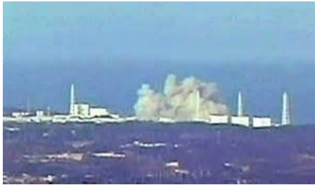
12-15 Mart 2011'de TÜM DÜNYA TV'lerindeki BU GÖRÜNTÜ, URANYUM YAKITIN İÇİNDE BULUNDUĞU ZİRKONYUMLU YAKIT BORU KILIFLARININ AŞIRI ISINARAK (1000 C DERECEDE), SUDAKİ HİDROJENİ OKSİJENLE AYRILMASI VE HİDROJENİN DE REAKTÖR (Containment) HAVASINDAKİ OKSİJENLE BİRLEŞEREK PATLAMALARIYDI (ATOM ROMRASI PATLAMASI DEĞİL!!)
