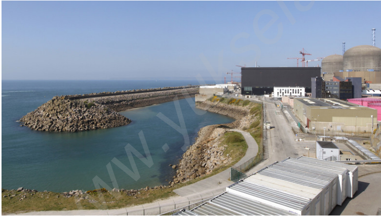
Şekil 1 ve 2: Flamanville Nükleer Santrali ve yeri. Resim’den görüldüğü gibi santralin ikincil devresi deniz suyuyla soğutulduğundan, ayrıca soğutma kuleleri bulunmuyor (Santralin, sadece atık gazların kontrollü olarak atıldığı, resimdeki gibi ince bir bacası görülüyor. Akkuyu Nükleer santralinde’da da soğutma kuleleri olmayacak)
